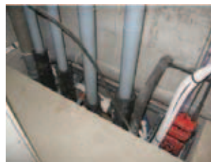
Fot. 4: Odkryty kanał instalacyjny w pokryciu budynku (Źródło: IngBEU)
