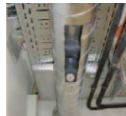
Rys. 5: Uszczelnienie przewodu instalacji wentylacyjno-klimatyzacyjnej (Źródło: IngBEU)
