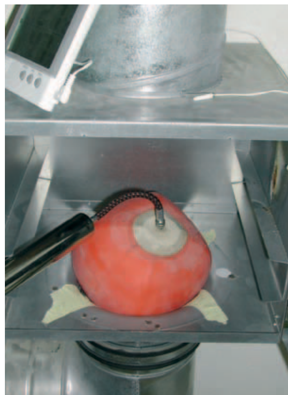
Fot. 4. Uszczelnianie otworu za pomocą dętki do piłki; dętkę po wsunięciu w otwór należy napompuwać (Źródło: BlowerDoor GmbH).
