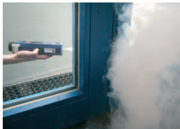
Fot. 3 Sprawdzenie szczelności stolarki okiennej za pomocą wytwornicy dymu (Źródło: BlowerDoor GmbH).
