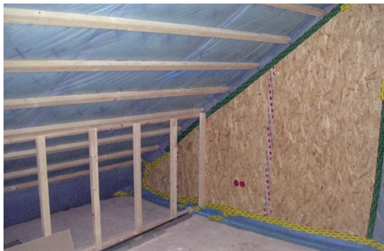
9. W tym przypadku należy sprawdzić szczelność trójkątnej przegrody zamontowanej w technologii suchej
