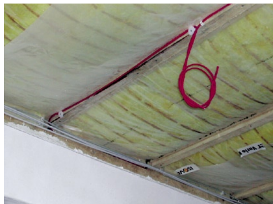
3. Instalację elektryczną układa się przed przystąpieniem do montażu paneli wykończeniowych
